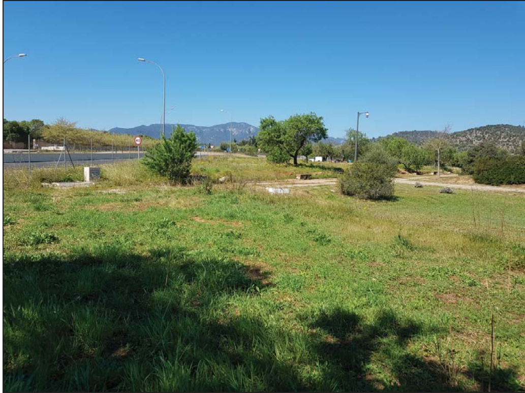
Foto 1. Inicio del tramo.
