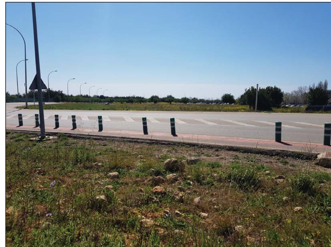
Foto 8. Cruce con la carretera de acceso al Parc Bit.
